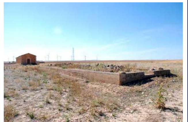
Vista general estructuras conservadas
