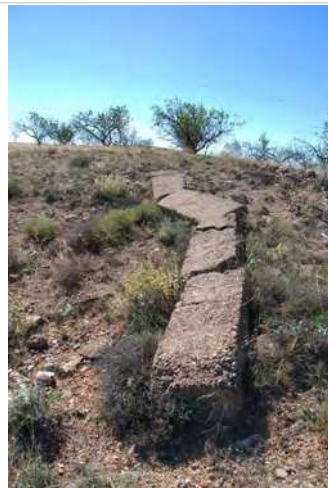
Restos de defensas en hormigón
