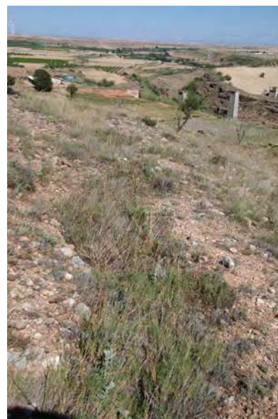
Ramal de trinchera
